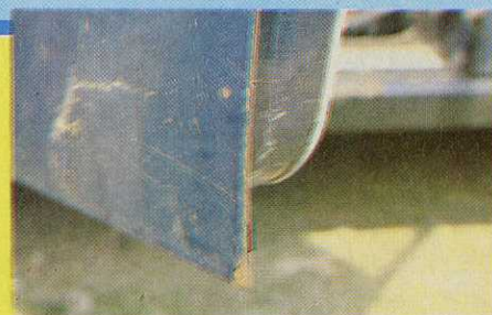
0. Vue générale de la tôle
