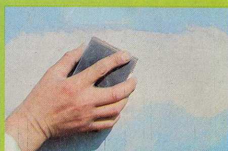
4. Poncer à l'aide d'une cale au papier n° P 80/P 120.
